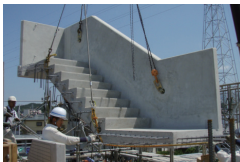
写真-2 PCa 工事
