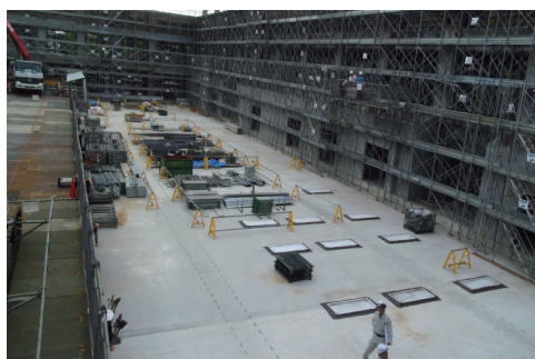
写真-1 通路の確保と 3S 確保状況
