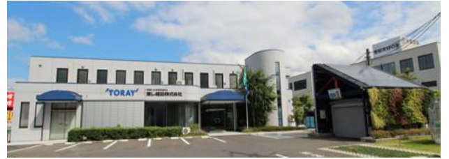
東レ建設京滋支店の全景
