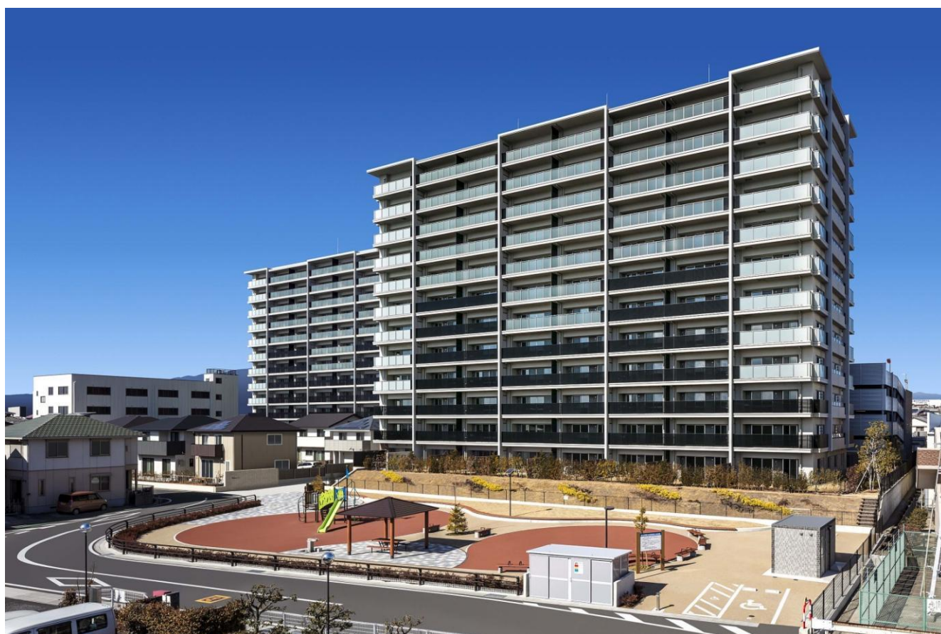
～マンション内電力融通システム「T-グリッドシステム®」を国内で初めて導入した分譲マンション～
