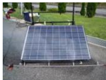
図-3:パネル C 表面噴霧状況
